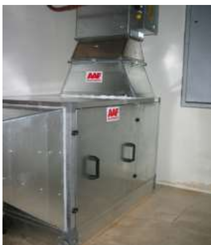
Obr. 2: Filtrační jednotka s vloženými filtry Purafil Select Chemisorbant
