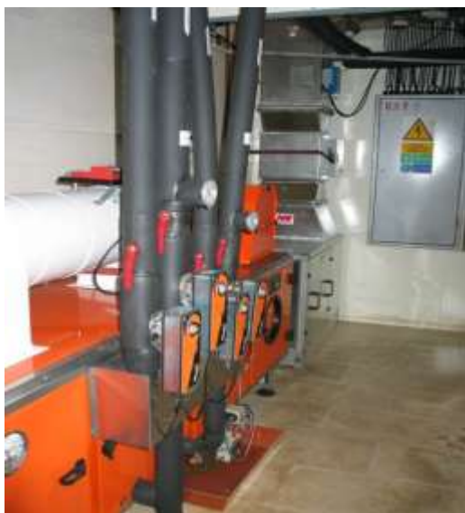
Obr. 1: Strojovna VZT pro depozitář Nový trezor s filtrační jednotkou (vzadu)
