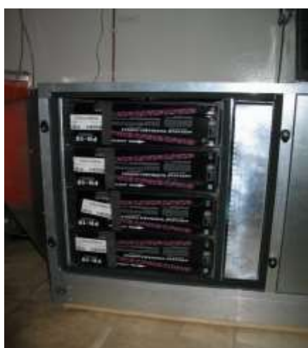
Obr. 2: Filtrační jednotka s vloženými filtry Purafil Select Chemisorbant
